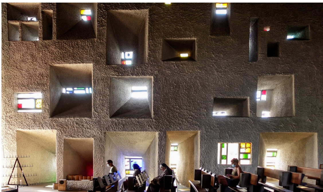
Fig 10. Detalle del muro de la Capilla de Ronchamp du Haut, Le Corbusier, 1950-1955.
